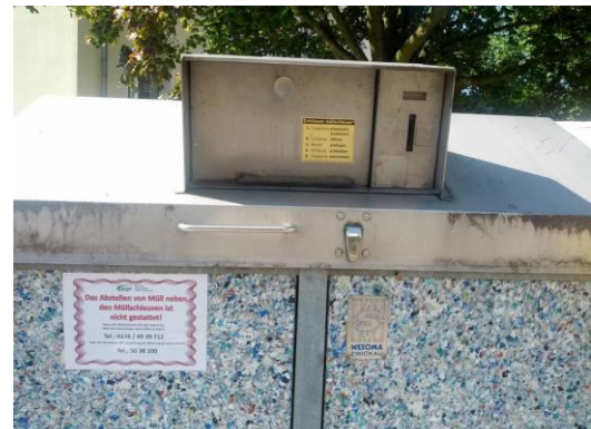
Abb. 7: Beispiel für eine Müllschleuse mit Identsystem bei der Wohnungsgenossenschaft „Elbtal“ Heidenau, Deutschland (Foto: S. Guerrero Mercado)
